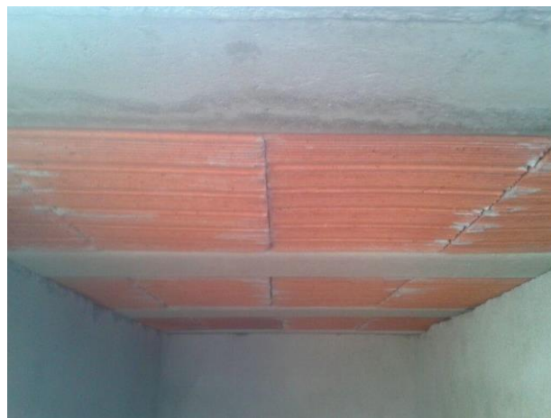
Figura 3 – Visão da parte inferior da laje com cobertura vegetal
