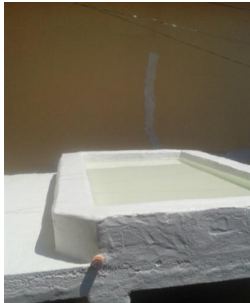
Figura 4: Impermeabilização de acordo com fabricante e teste estanqueidade.
