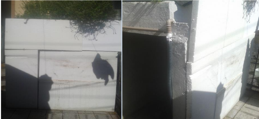
Figura 8 : Posicionamento placas de isopor
