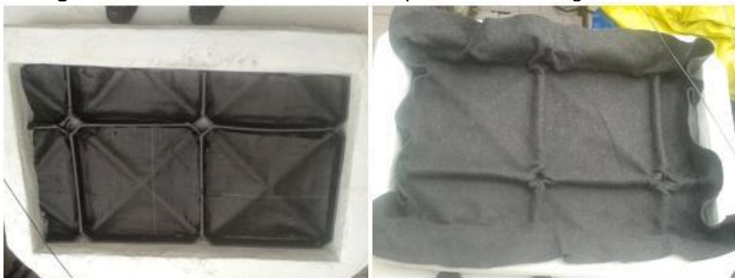
Figura 5: Posicionamento dos módulos plásticos e manta geotêxtil.
