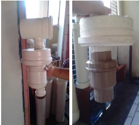
Figura 8. Métodos de fechamento da entrada do reservatório
