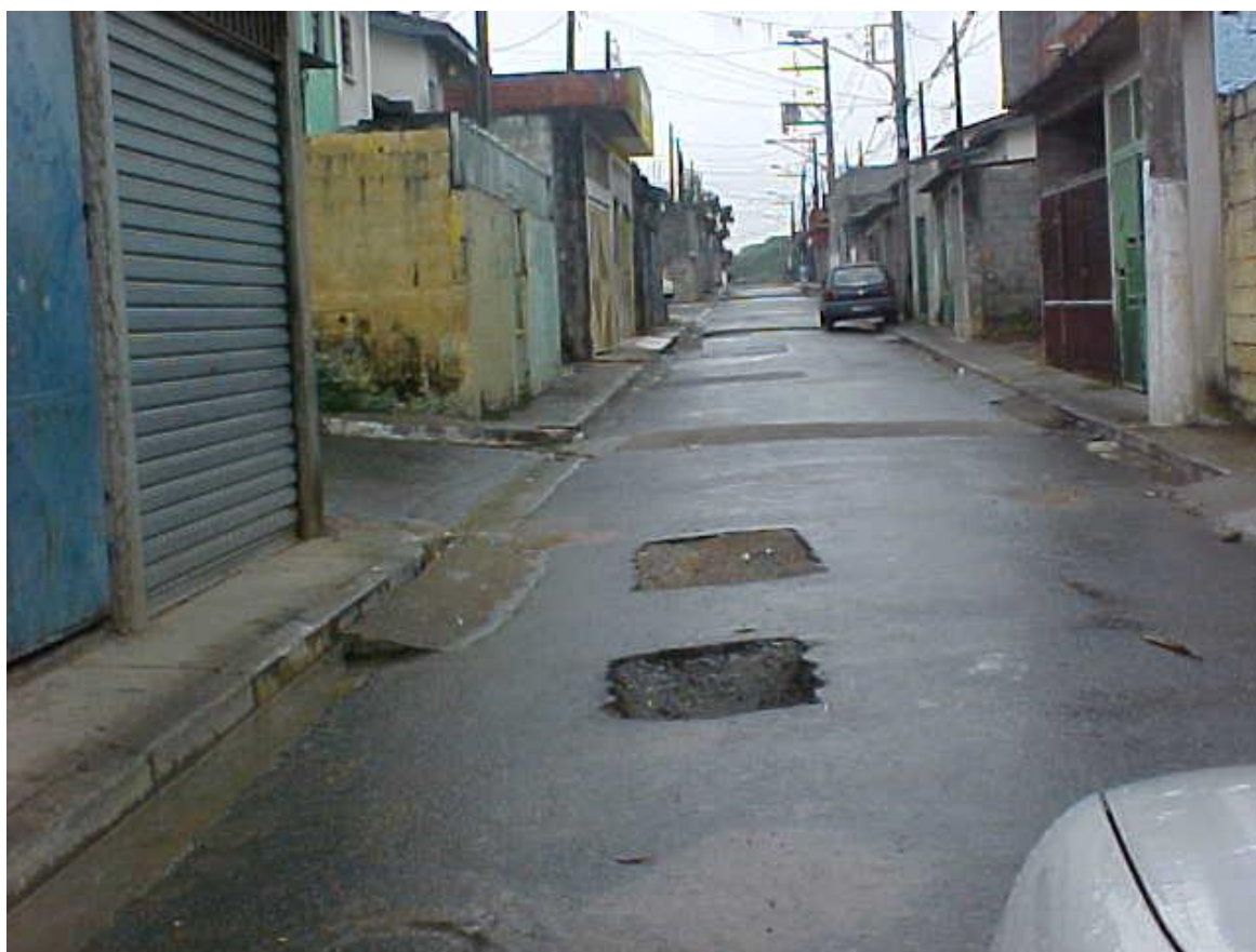
Figura 48 – Exemplo de recorrência de vazamentos
