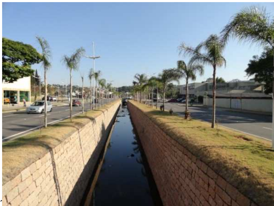
Figura 25: Córrego do Mato próximo ao ponto que irá desaguar no Rio Jundiáí. Toda APP ocupada por edificações.
