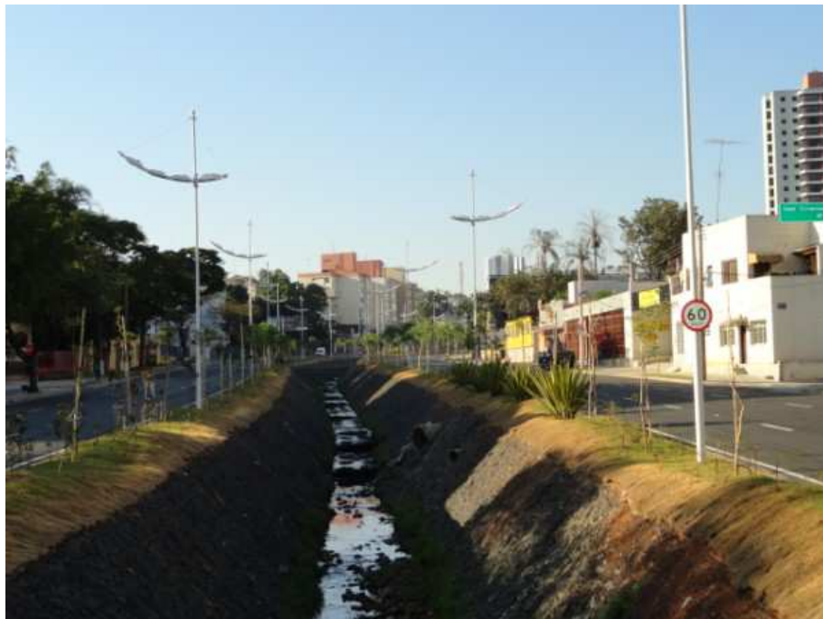
Figura 16: Vista do leito do Córrego do Mato, fundo permeável e canais em pedra.
