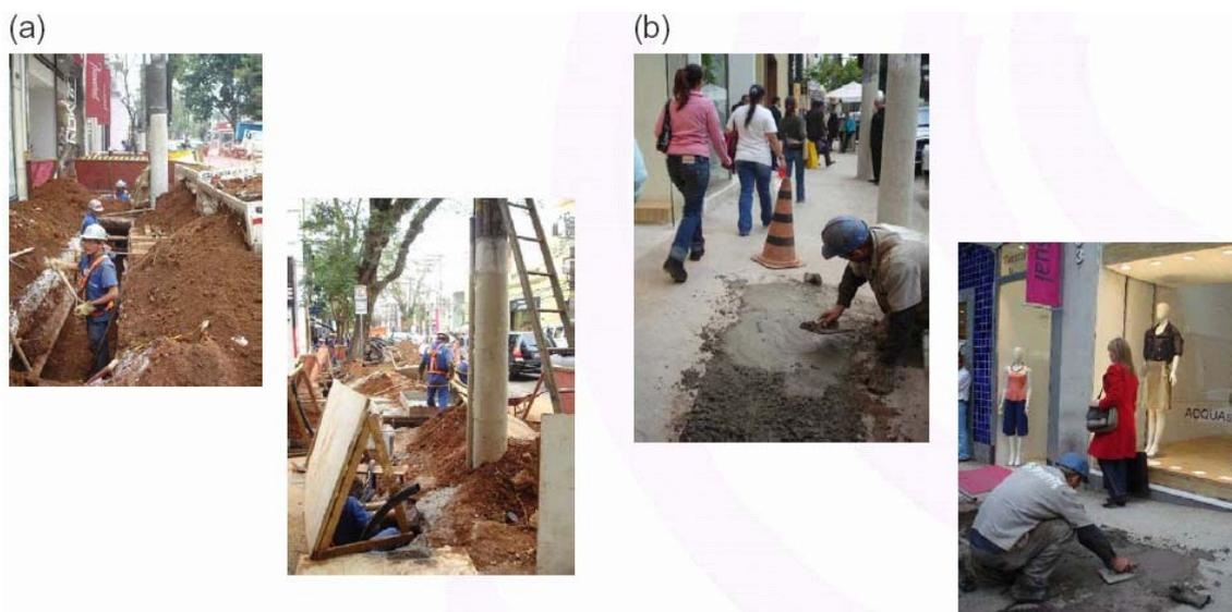
Figura 33. (a) Valas longitudinais abertas no passeio para aterramento dos fios elétricos; (b) Serviços de reposição do pavimento das valas pontuais abertas no passeio
