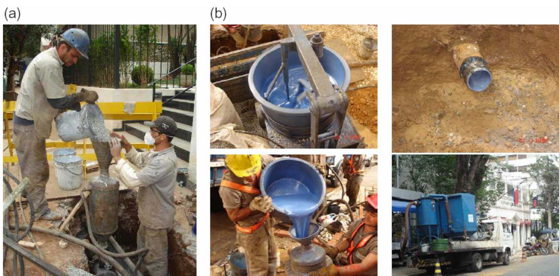
Figura 41. (a) Colocação de agregado para limpeza da tubulação; (b) Mistura e aplicação da resina epóxi e caminhão dotado de coletor e filtro
