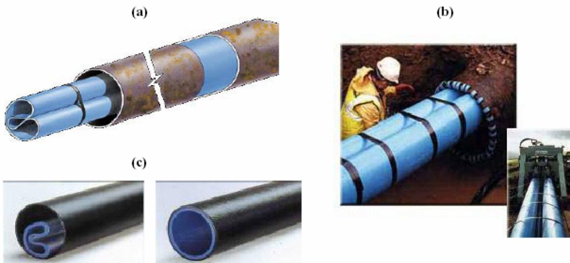
Figura 47. (a) Tubo dobrado; (b) Imagem da inserção do tubo de parede dobrada; (c) Detalhe do tubo dobrado e detalhe do tubo expandido no interior da rede
