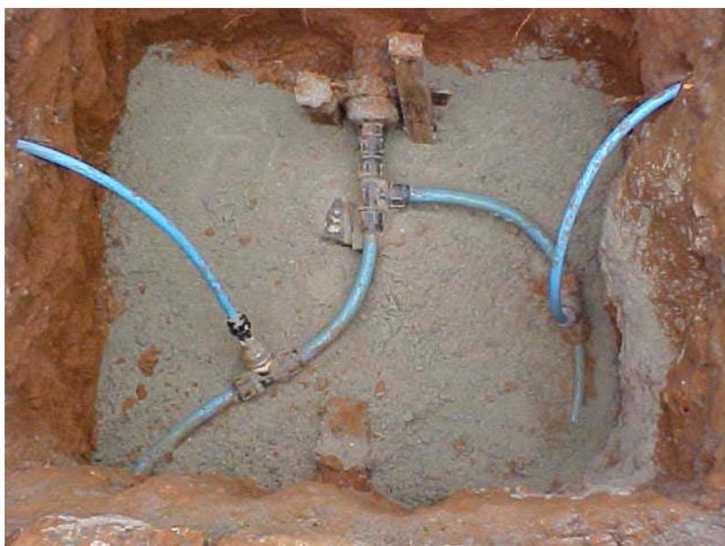
Figura 6. Tubulação de polietileno em forma de anel ligada a dois imóveis
