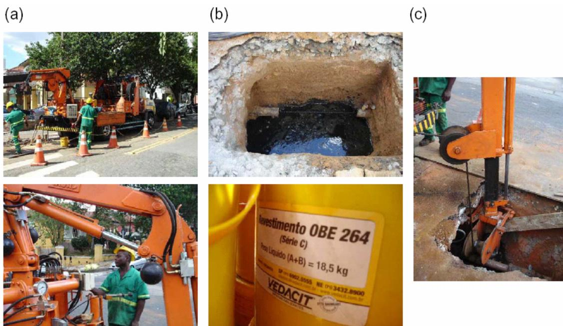
Figura 38. (a) Procedimento de limpeza da tubulação; (b) Remoção das incrustações por arraste mecânico e produto da mistura do revestimento; (c) Detalhe das roldanas do equipamento do processo de arraste
