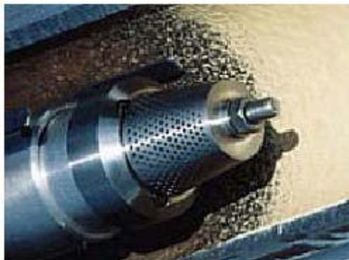
Figura 39. Aplicação de revestimento de resina epóxi
