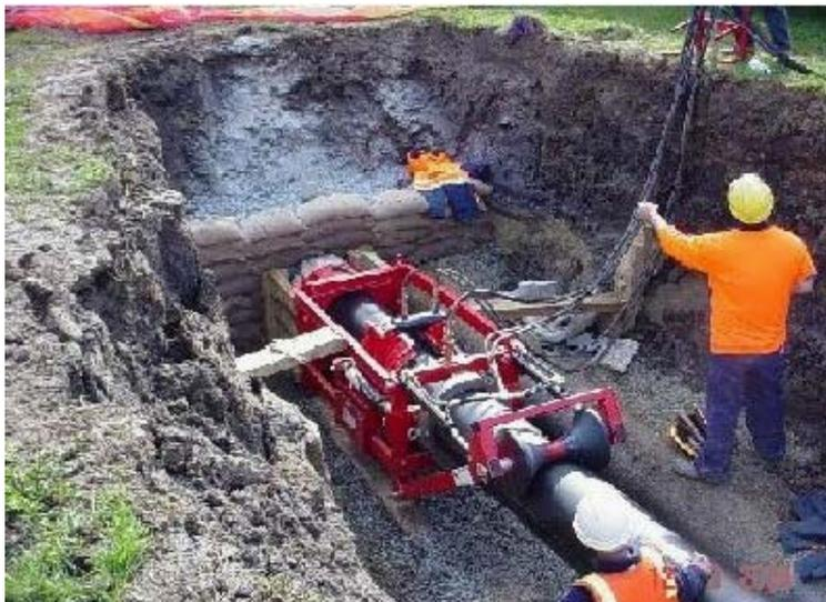
Figura 46. Redução de diâmetro por esmagamento ou rolldown
