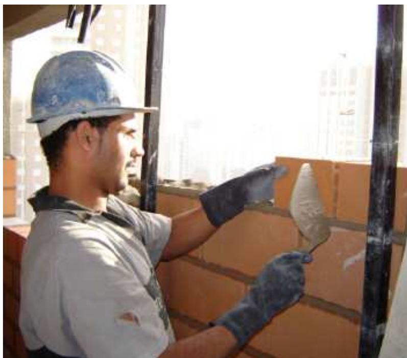
Figura 46 – Assentamento de blocos cerâmicos
