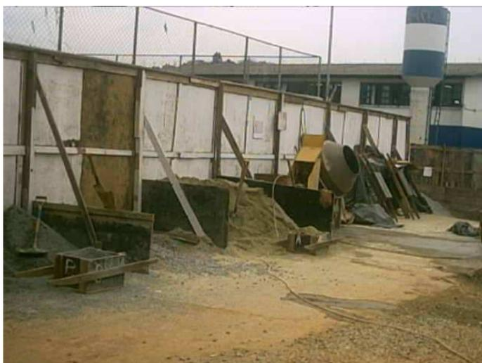
Figura 27 – Central para preparação de concreto e argamassa em C-2.
