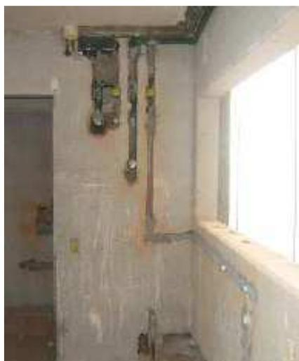
Figura 48 – Recorte de paredes para instalações hidráulicas
