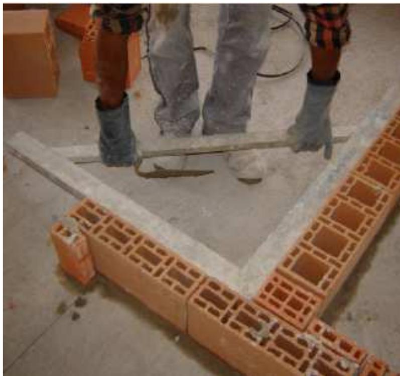
Figura 45 – Marcação para elevação de alvenarias
