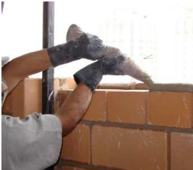
Figura 47 – Aplicação de argamassa de assentamento com uso de bisnaga dosadora
