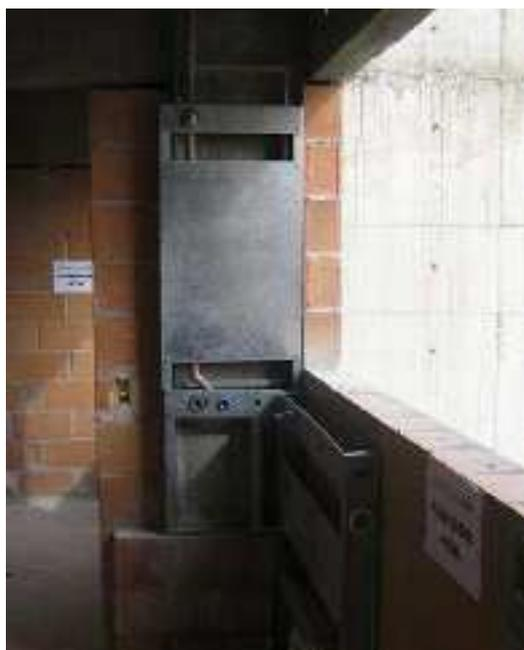
Figura 49 – Caixa metálica para passagem de tubulação hidráulica.
