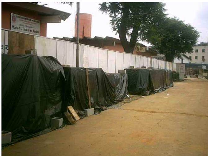
Figura 26 – Blocos de concreto acondicionados em pilhas cobertas em C-2.
