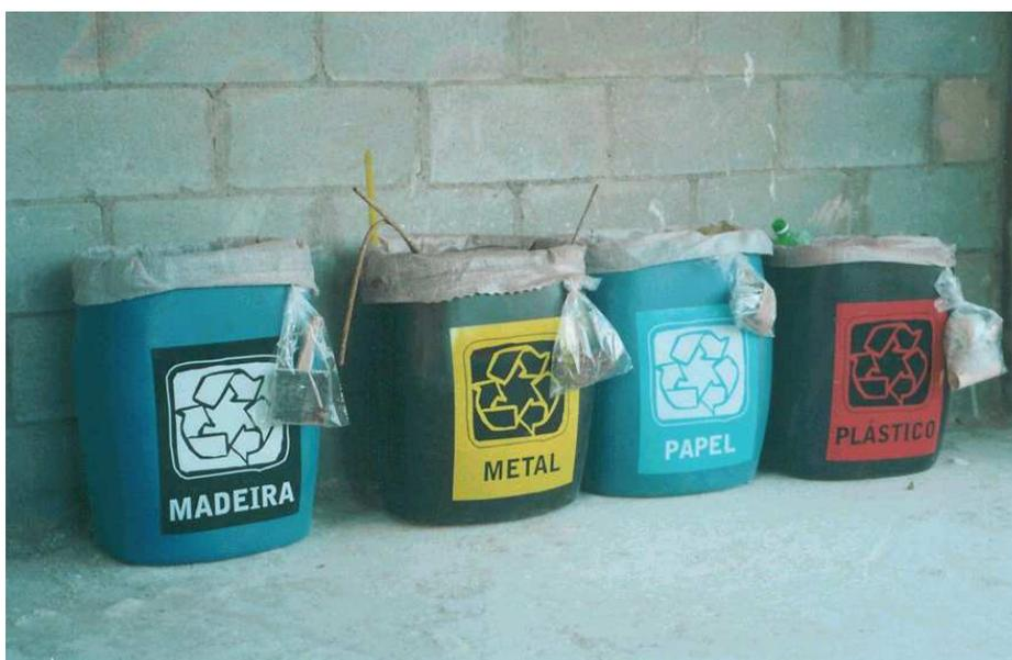
Figura 24 – Dispositivos para acondicionamento inicial de resíduos em pavimentos-tipo.
