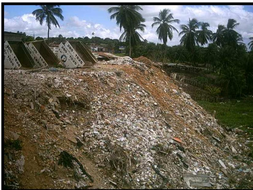
Figura 13 – Bota-fora operado por transportador em Natal – RN
