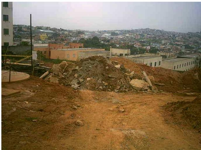
Figura 30 – Pilha com resíduos de alvenaria e concreto em C-2.
