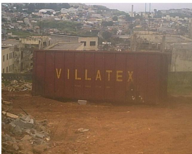
Figura 29 – Caixa estacionária com capacidade de 39 m<sup>3</sup> utilizada para acondicionar resíduos de madeira em C-2.
