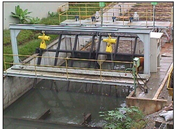
Figura 16 – Detalhe da Grade da Estação de Flotação e Remoção de Flutuantes do Parque do Ibirapuera Fonte: Fotos da Autora (2004)
