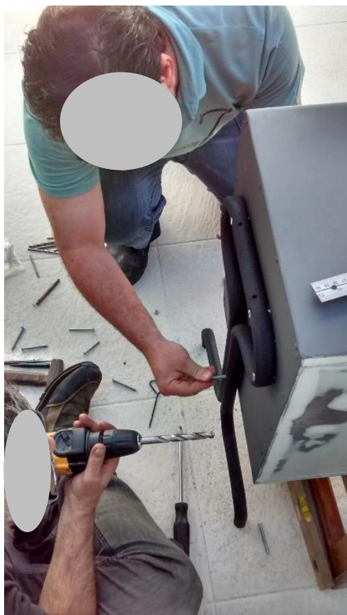
Figura 40 – Fixação do apoio (pé)
