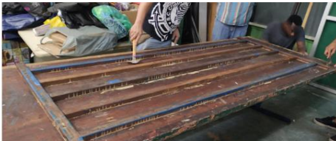
Figura 64: Reforço sob a mesa para fixação do pé da prancheta
