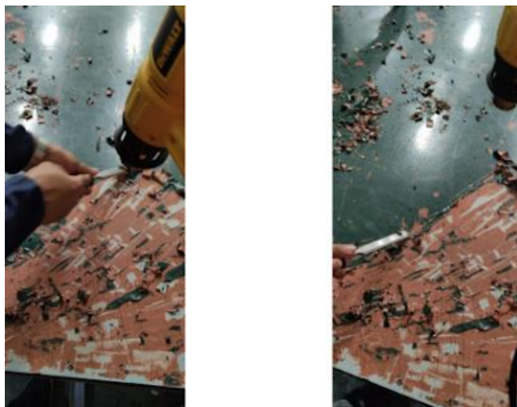
Figura 63: Raspagem da mesa para a reforma
